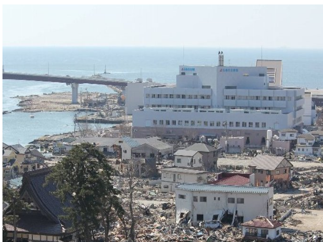
診療不能となった石巻市立病院
