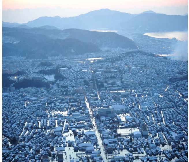
津波により冠水した石巻市街(陸上自衛隊提供)
