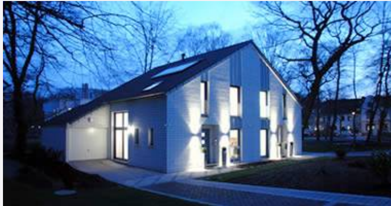
Fraunhofer Innovation Center Intelligent House Duisburg www.inhaus-duisburg.de
